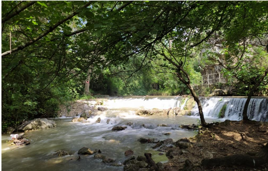
La chute d'eau destinée à briser la force du courant.
